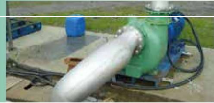
Montaje en superficie para facilitar el acceso
