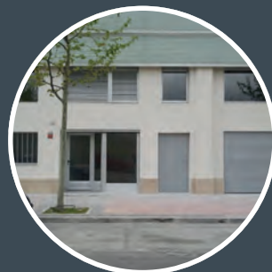
Sede Zona Centro
